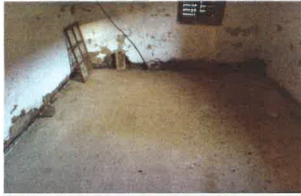
Na Kaplovi domačiji urejajo sanitarni prostor.
