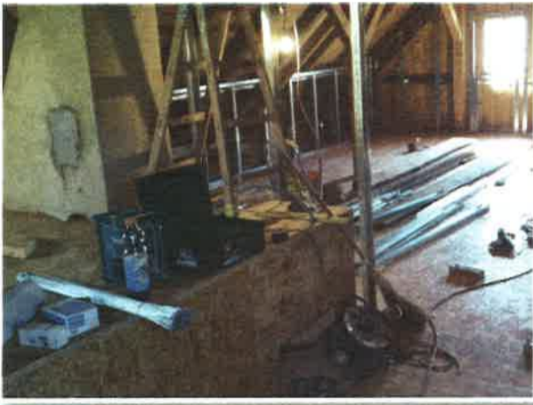
Urejanje spalnih in sanitarnih prostorov v mansardi Grafonževe domačije
